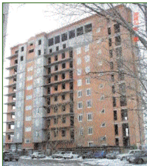
Рис. 1 Внешний вид здания
