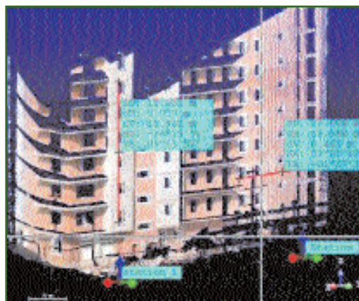
Рис. 2 Фрагмент отсканированных стен здания в виде «облака точек»
