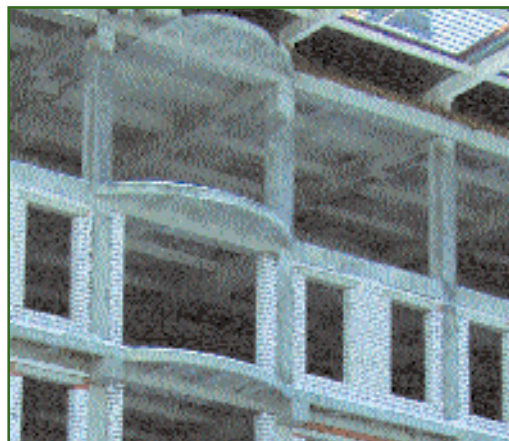
Рис. 1 Фасад строящегося здания в городе Чебоксары
